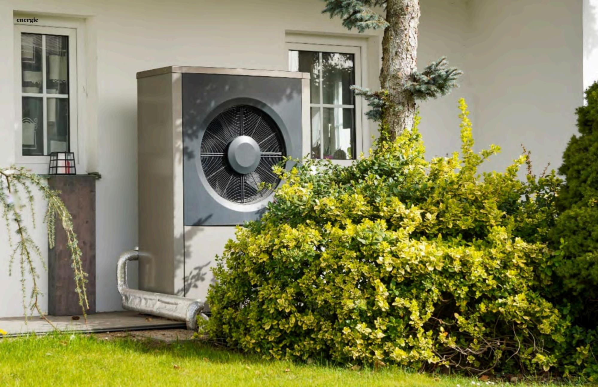
**Heizen mit Zukunft:** Wärmepumpen gelten als Schlüsseltechnologie der Wärmewende. Aus einer Kilowattstunde Strom macht eine effiziente Wärmepumpe drei bis fünf Kilowattstunden Wärme. Dank staatlicher Förderung von bis zu 70 Prozent sind die Systeme heute erschwinglicher denn je
